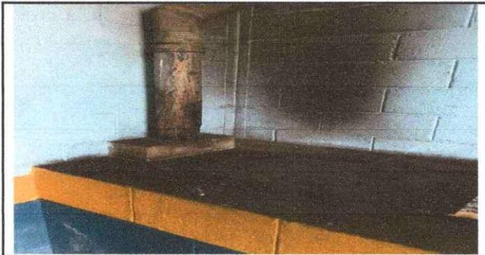
Foto 5: Sustitución de plancha y cambio de chimenea en area de cocina por deterioro por el calor del fuego.
